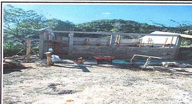
Foto 2: Así fue que la construcción de la nueva escuela llegó su altura.
