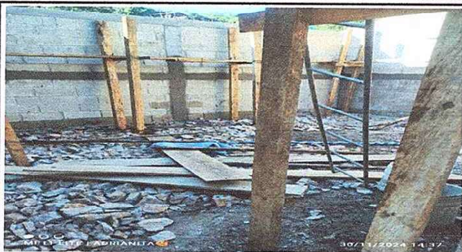
Foto 1: Así fue el periodo durante la construcción de la escuela.
